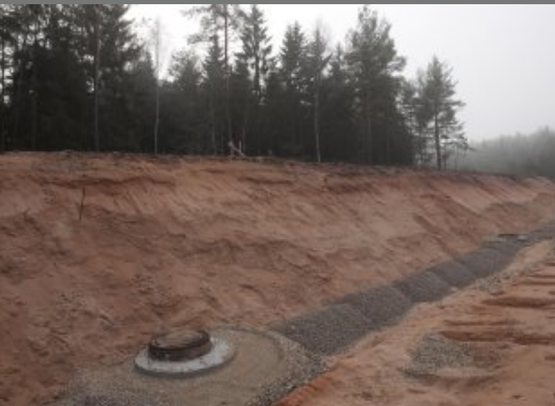
Erweiterung eines Parkplatzes an der A3
