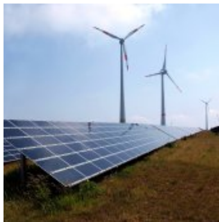
Bild: Windpark Schneebergerhof. Im Vordergrund eine Photovoltaikanlage mit Dünnschichtsolarzelle Quelle: Armin Kübelbeck auf Wikipedia
